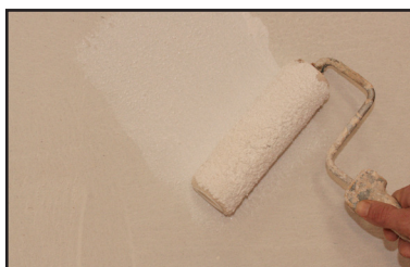
Schritt 1 : Tragen sie die Haftbrücke mit Hilfe einer Rolle von ARGILUS auf.
