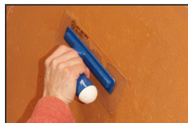
Schritt 4 : Nach Ablauf der Hälfte der Trockenzeit wird der Verputz mit Hilfe einer flexiblen Plastikspachtel verdichtet.
