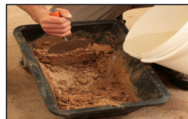
Schritt 2 : Anmischen des Verputzes mit Wasser maschinell.
